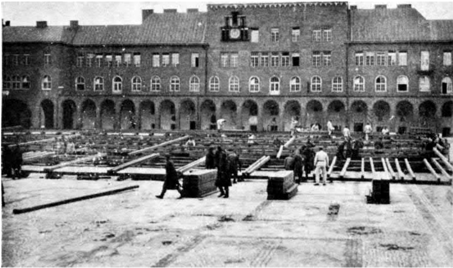
Nézőtér-építés a szege-di Dómtéren
