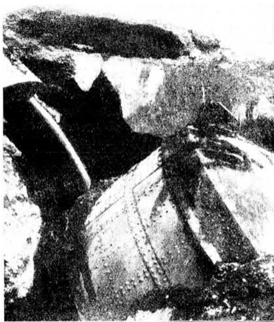
A maubeugei Fort des Sart romjai a hatodik 42 centiméteres bomba becsapása után. Be tón és páncéltorony pozdorjává törve omlott össze
