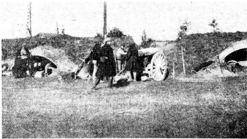
Magyar tüzérség fedezékben az északi harctéren. Valóságos művészettel volt felépítve az üteget rejtő fedezék. A katonák és a muníció számára földbe épített, srappellbiztos boltozatos üregeket vájtak
